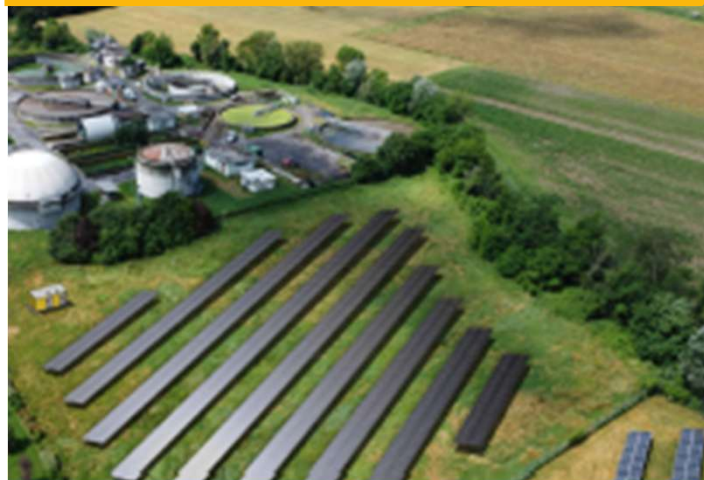
DEPURATORE DI FIDENZA
