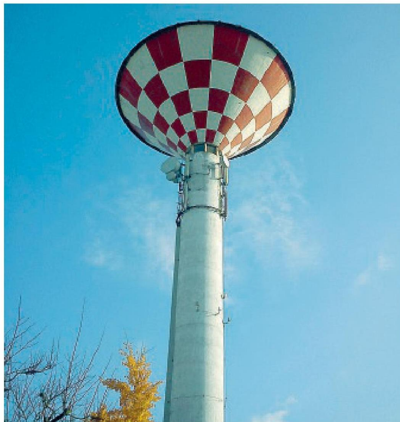
A secco Un guasto all'acquedotto di Torrile.
