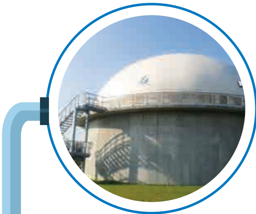
Il digestore dell'impianto di depurazione di Fidenza
