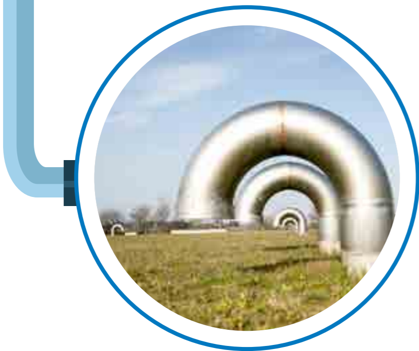
Prese d'aria per le vasche di stoccaggio interrato dell'acquedotto di Lodesana (Fidenza)
