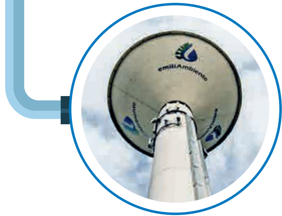
Serbatoio pensile presso la centrale di Priorato (Fontanellato)
